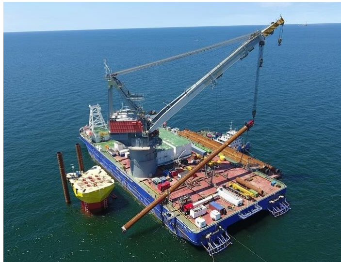
Şəkil 1. “Qurban Abasov” kran gəmisi DP iş rejimində
